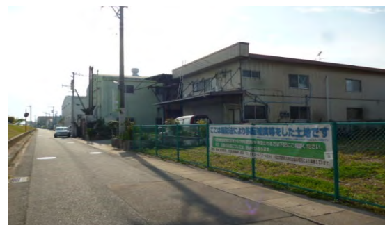
移設後 <道路に面する場所に移設>
