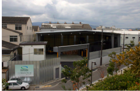
平成18年度整備した工場兼事務所(伊丹市森本7丁目)
