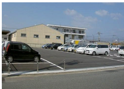
平成17年度整備した駐車場(福岡市東区社領3丁目)
